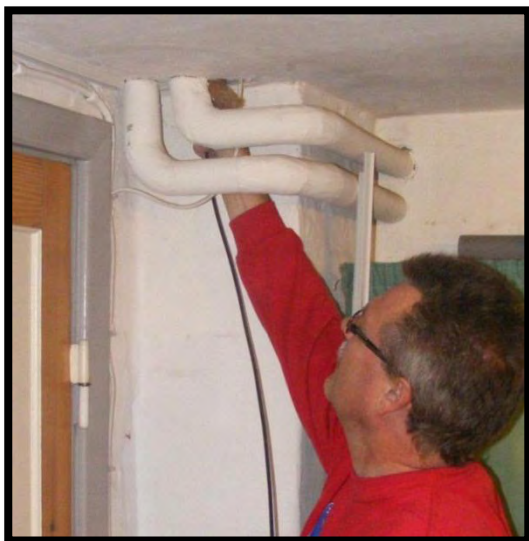
Billede 14 - Kabel føres gennem etageadskillelse
