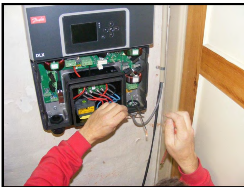
Billede 24 - Tilslutning af inverter
