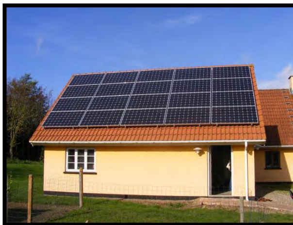
Billede 27 - Parallelmonterede solceller, på anneks
