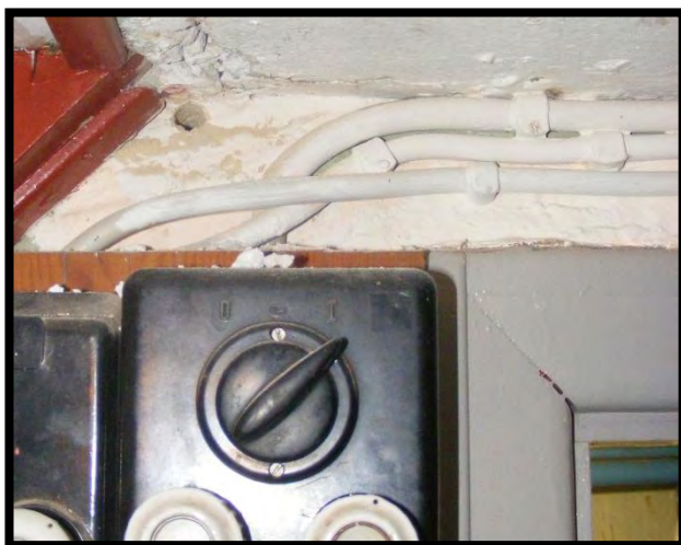
Billede 19 – Kabler fastgjort med kabelklips (20)
