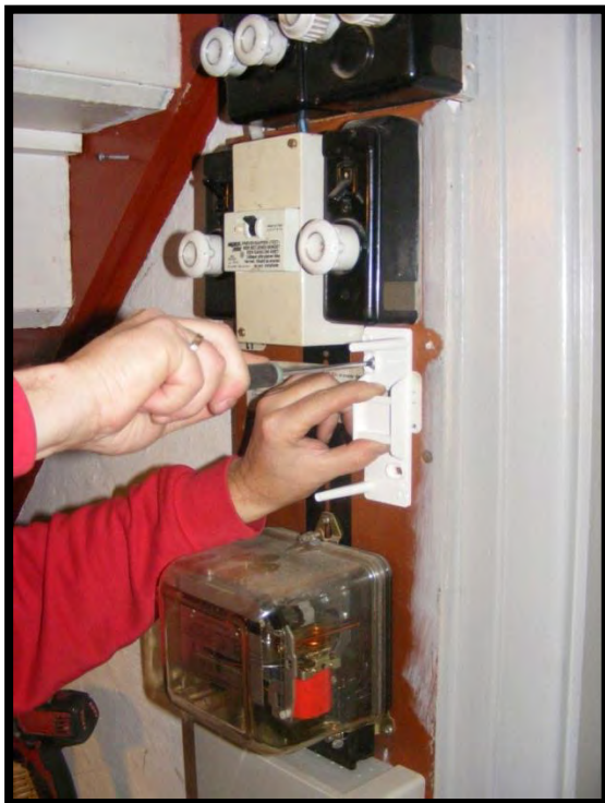
Billede 26 - Montering af ny fejlstrømsafbryder
