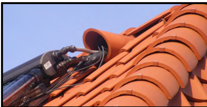
Billede 21 - Et solvarmeanlægs slanger samt kablerne fra solcelleanlægget er ført gennem en tudsten
