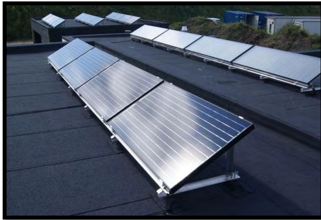
Billede 28 – Skråstillet anlæg på fladt tag
