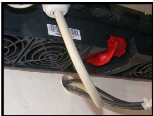
Billede 18 – Kabler ført skjult i rør i væg (1)
