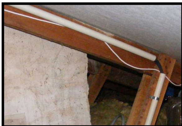
Billede 15 – Kabler ført i rør, fastgjort med bøjler (4)
